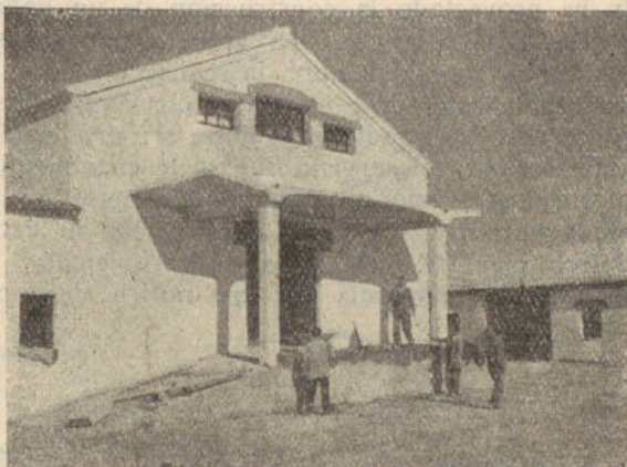
Fachada de la bodega.
